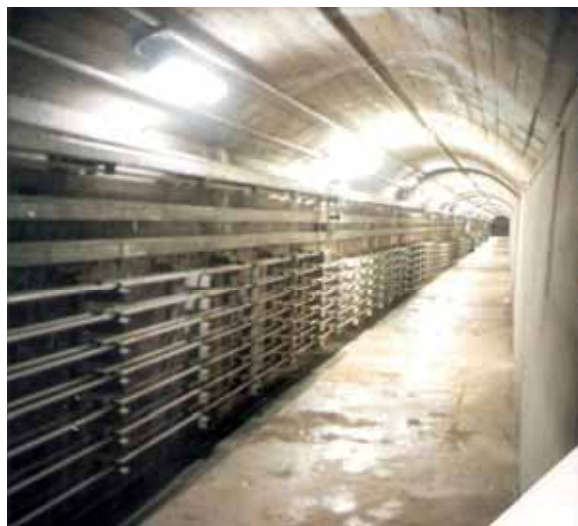
Galleria con i tubi dell'olio e cavi elettrici
